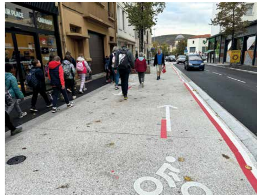
À Clermont-Ferrand, l'aménageur a privilégié la piste au détriment du trottoir ce qui fait que l'on retrouve des piétons sur la piste.
