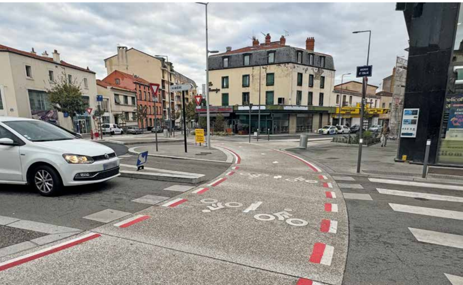
Exemple du giratoire de Clermont-Ferrand : piste bidirectionnelle et priorité aux piétons et vélos.
