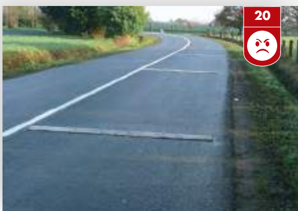
Un morceau de bande rugueuse très fréquemment utilisé.
